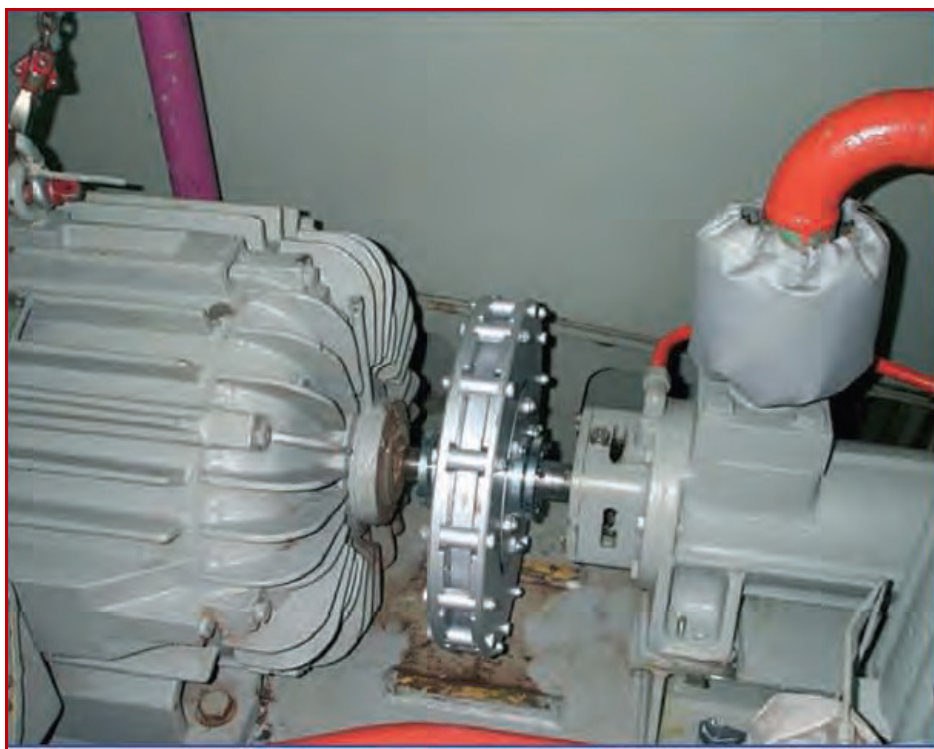
Figuur 14.14: Moderne slip koppeling met permanent magneet technologie.
