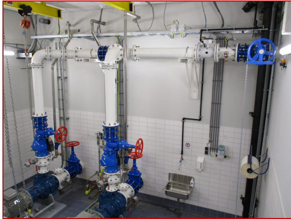
Fig 7.10: Slank ontwerp persleiding stelsel.
